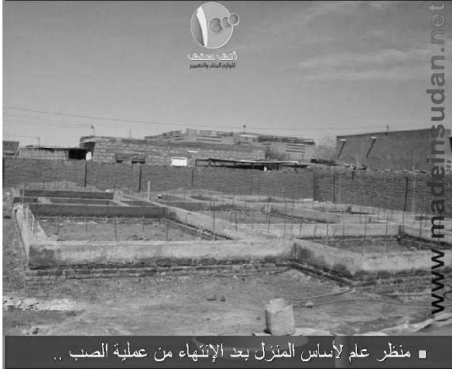
الصورة (9-2) توضح المنظر العام للأساس بعد الانتهاء من عملية الصب
