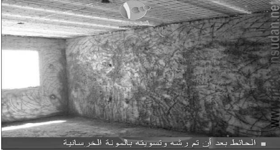
الصورة (2-17) توضح الحائط بعد الرش والتسوية بالمونة
