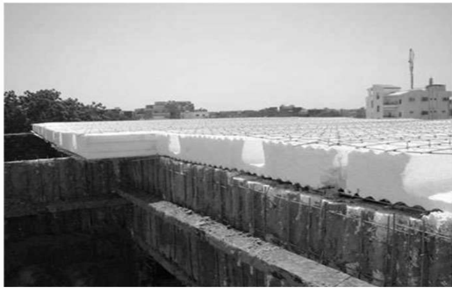
الصورة (5-2) توضح اللوح الارضي او لوح السقف
