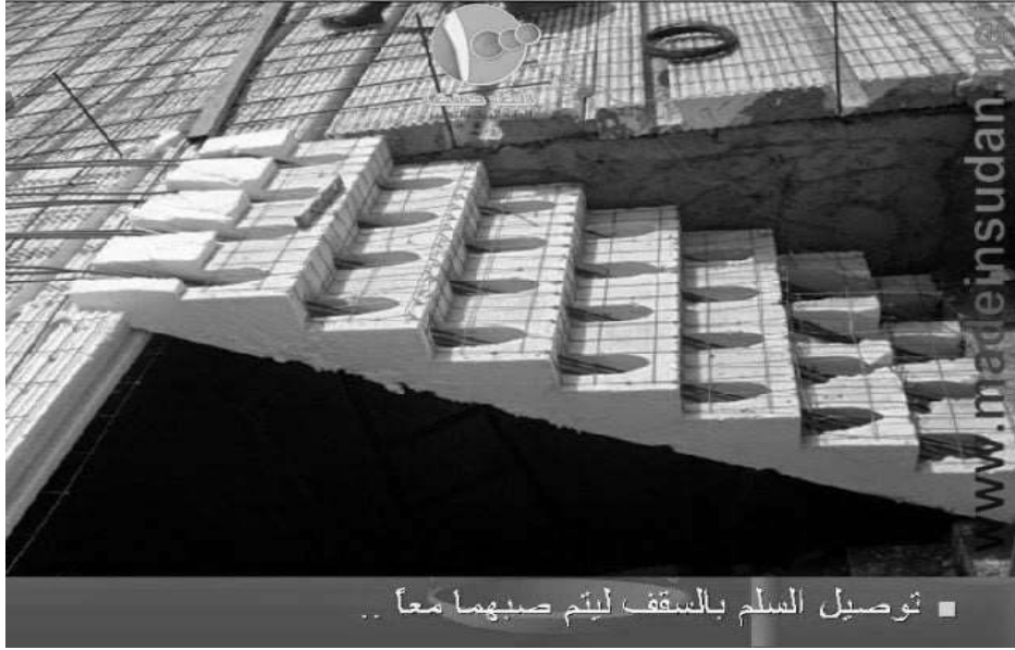
الصورة (2-14) توضح توصيل السلم بالسقف قبل صبهما
