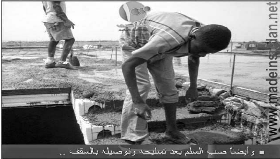
الصورة (2-14) توضح توصيل السلم بالسقف قبل صبهما
