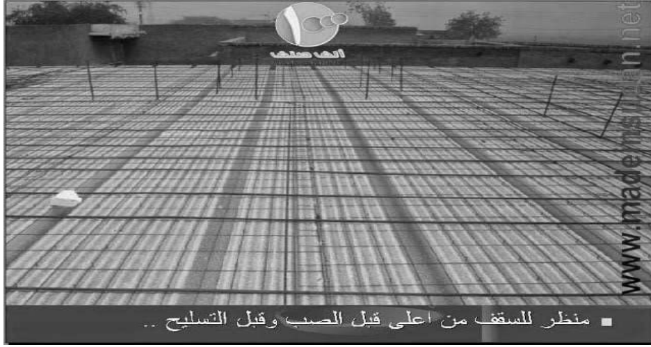
الصورة (2-12) توضح السقف من الاعلى قبل التسليح والصب
