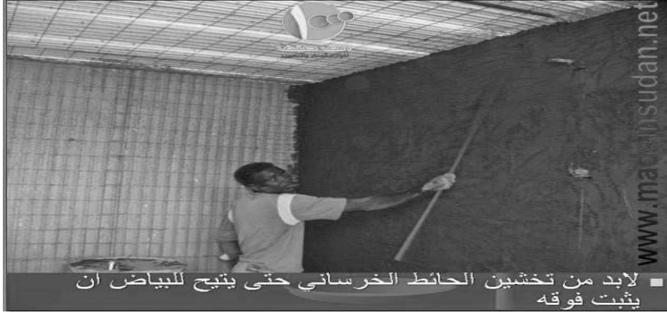
الصورة (2-16) توضح عملية تخشين الحائط الخرساني
