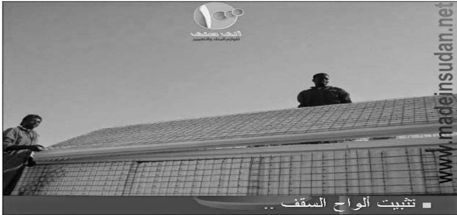
الصورة (11-2) توضح تثبيت ألواح السقف
