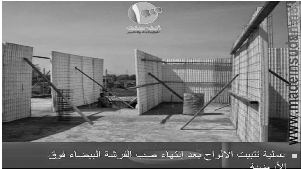
الصورة (10-2) توضح عملية تثبيت الألواح
