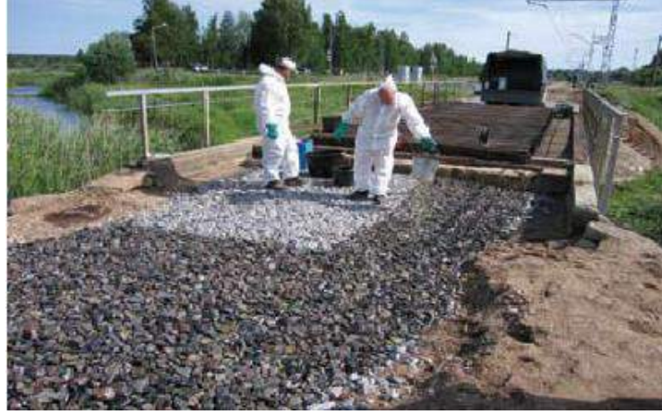
صورة رقم (4-12) (عملية رش البلاست بالمواد المثبتة)
