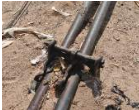
صورة 3-3-16 ( أجزاء تشغيل الإشارات و التحويلة )
