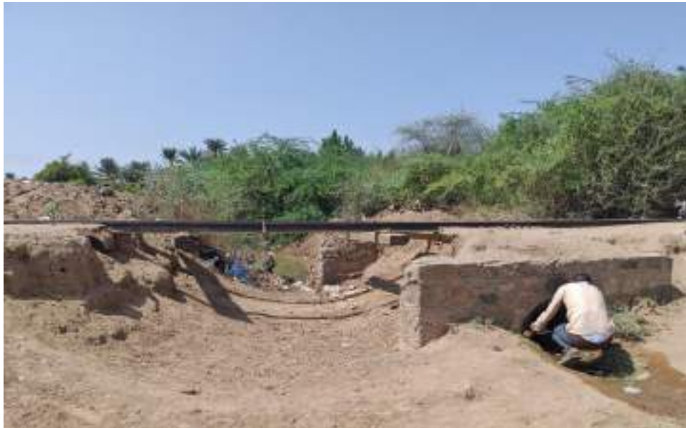
صورة 19-3-3 (نحر في ردميات السكة بسبب مياه الأمطار )
