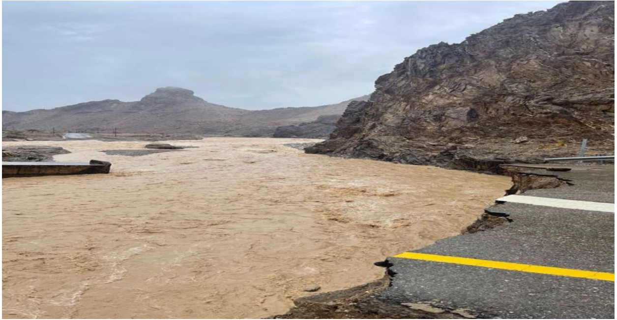
الشكل (2-10): يوضح تدفقات السيول المفاجئة أثرها ف تدمير وجرف الطرق
