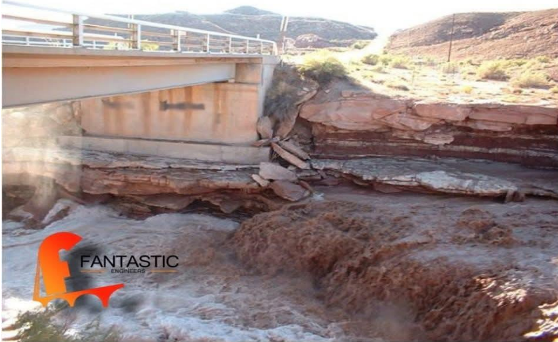
الشكل (2-14): يوضح تأثير النحر في تكوين حفر حول دعائم الجسور
