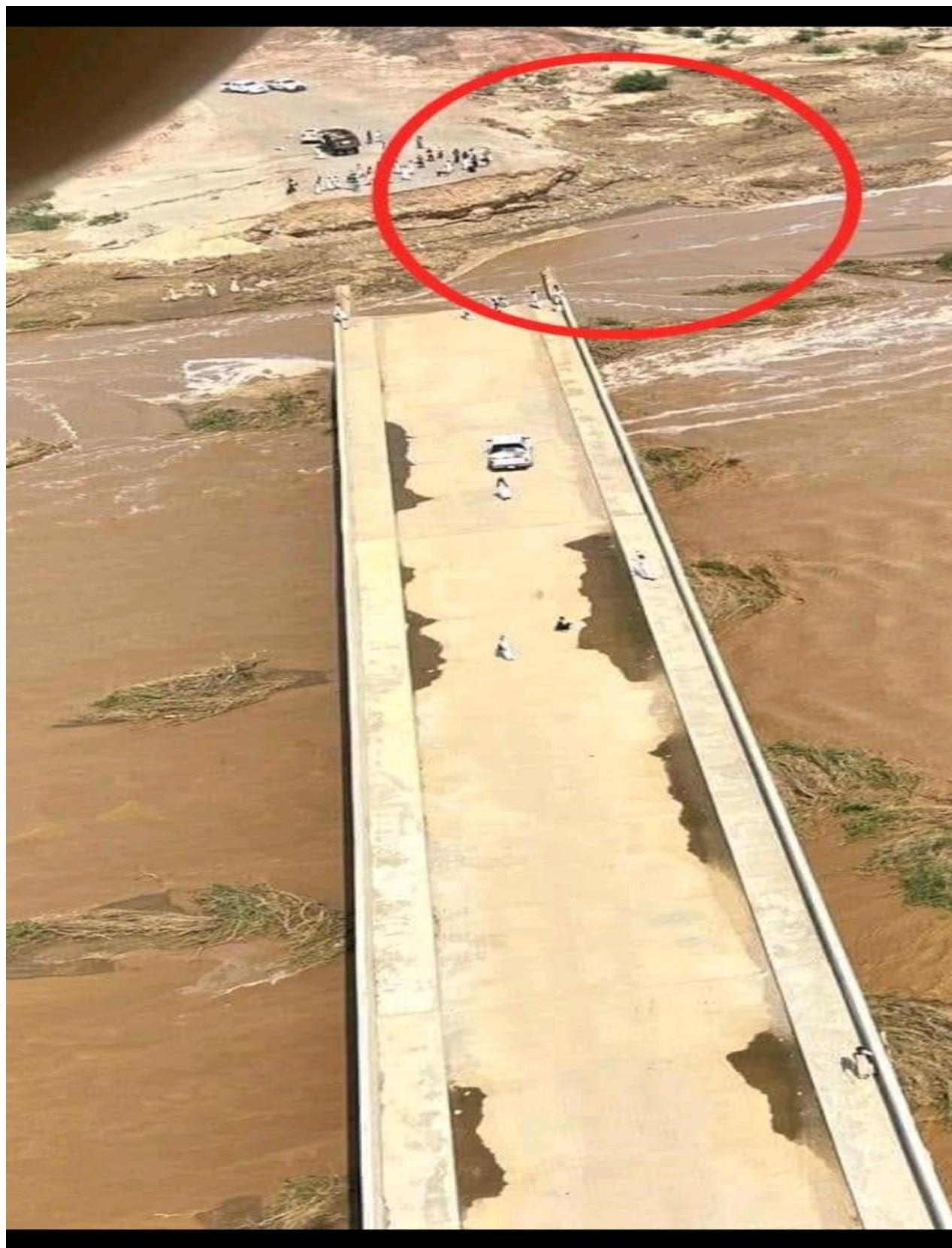
الملحق(3): يوضح النحر في الردميات نتيجة الطمي مما أءاء إلى إنقطاع الطريق للكبري وتغير مجرى الخور.
