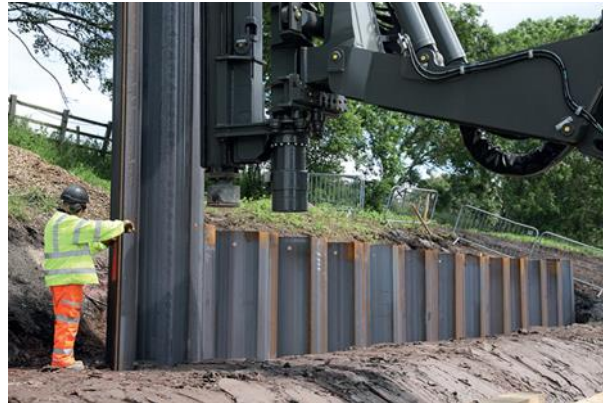
شكل (2-5) طريقة تركيب صفائح الفولاذ الساندة
