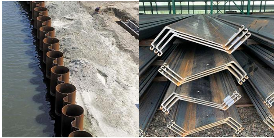
شكل (2-4) أشكال مختلفة لصفائح الفولاذ الساندة
