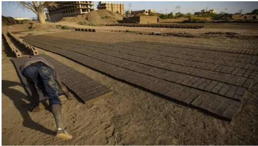
صورة رقم (2-2) توضيح تشكيل الطوب الأخضر
