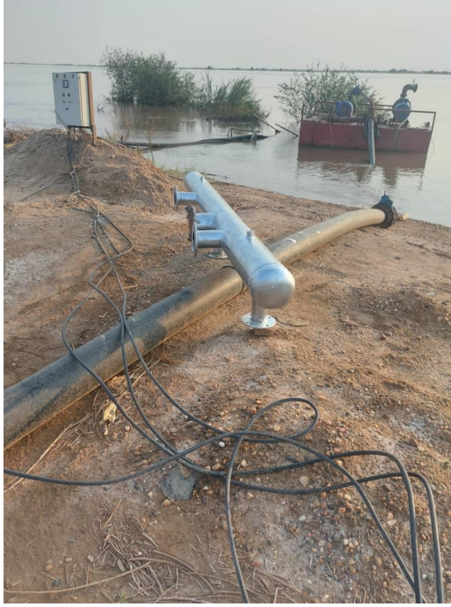
الشكل (9.3) يوضح طلمبة لرفع الماء من المصدر
