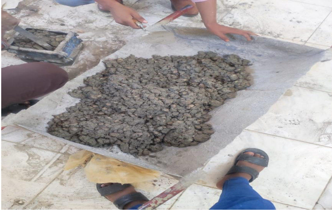
صورة(3-3) توضح الخلطة الخرسانية قبل الصب
