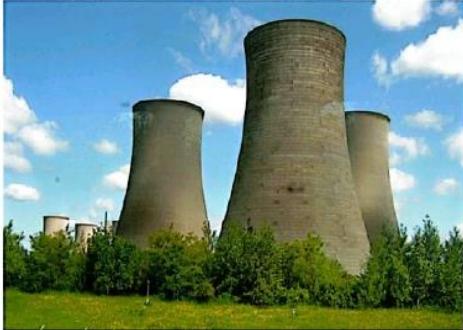
الشكل (١١-٢) أبراج التبريد المستخدمة في محطات القدرة
